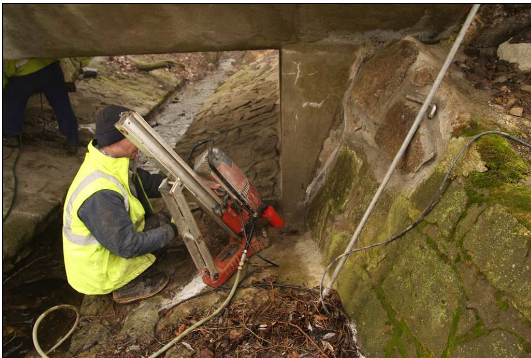
Obr. č. 8 – provádění vrtu Š1 - opěra Olomouc
